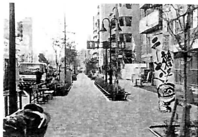
一部完成した「山手通り」
