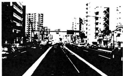
現在整備中の山手通り
