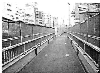
JRを跨ぐ『陸橋』（次号で詳述）
