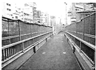
JRを跨ぐ『陸橋』（次号で詳述）
