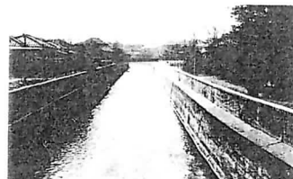
改修工事後の亀鈴橋（東中野5丁目）
