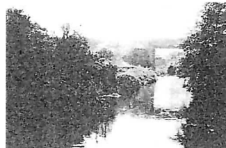
改修工事前の万亀橋（東中野1丁目）
