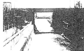
同上改修工事終了後の万亀橋
