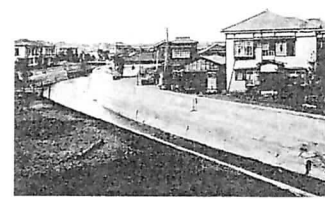
同上改修工事終了後の柏橋
