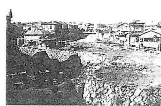
改修工事前の柏橋（東中野1丁目）
