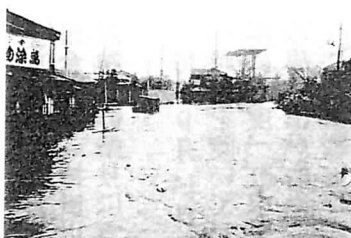
☆戸田平橋（高田馬場）付近の出水
